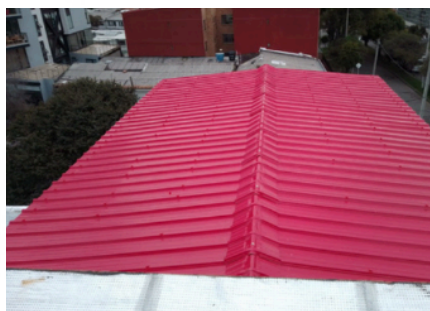
Después de intervención
