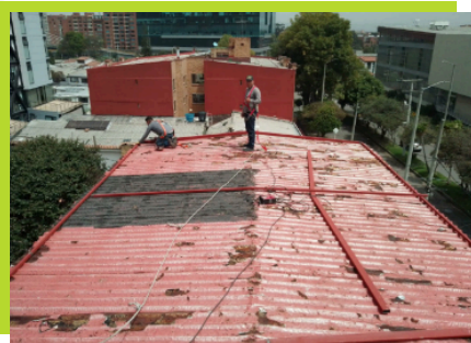
Antes de intervención
