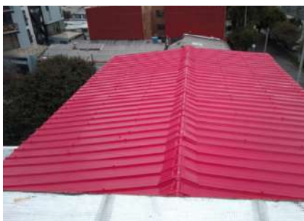
Después de intervención
