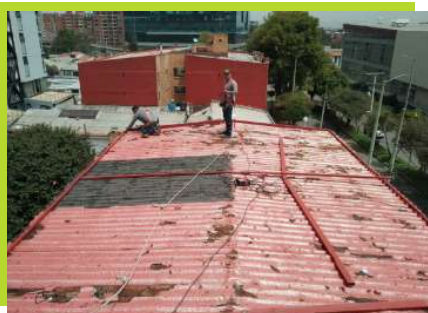
Antes de intervención
